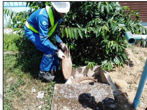
สถานีที่ 2 ท่อน้ำทิ้งหลังออกจากระบบบำบัดน้ำเสียของบ้านพักเจ้าหน้าที่
