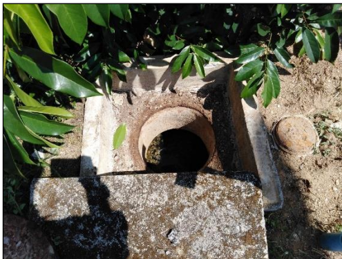
สถานีที่ 2 ท่อน้ำทิ้งหลังออกจากระบบบำบัดน้ำเสียของบ้านพักเจ้าหน้าที่
